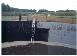
Leahy Ltee. Sherrington songeait à remplacer l'ancienne membrane qui protégeait un réservoir de béton. L'ancienne membrane se fissurait en raison des toxines exécrées par les animaux. L'eau ne cessait alors de pénétrer dans le plancher en béton. Elle devait rapidement trouver une solution à ce problème pour éviter de réparer le béton chaque année. La nouvelle membrane devait présenter une excellente résistance chimique et une imperméabilisation exceptionnelle.
